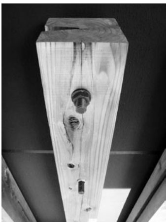
木格子上端部の詳細。格子1本につき上下2本ずつの SUS 製 M16 アンカーボルトで外壁(PC板)に緊結している。
